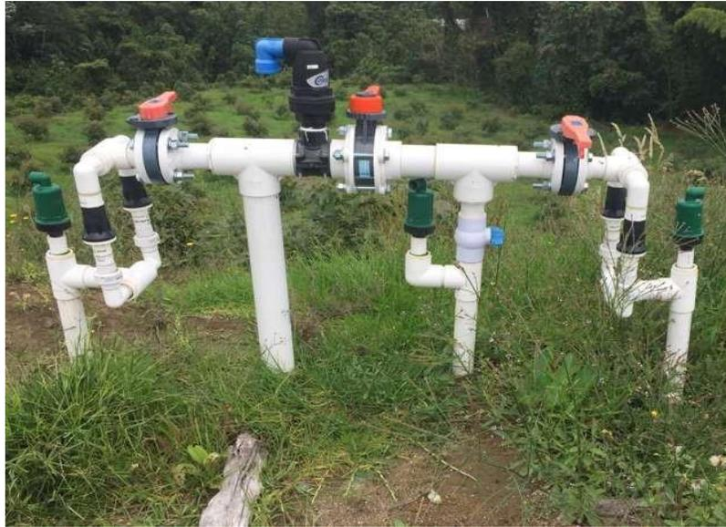
Fig. 5 Módulo típico para un sector de riego
