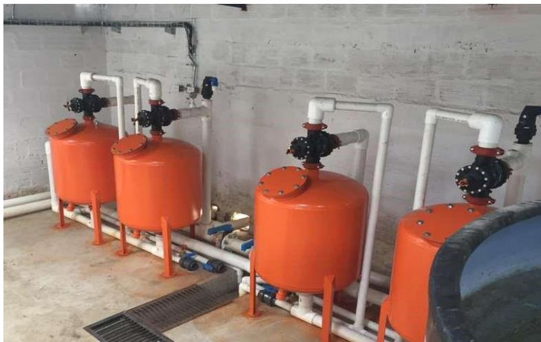
Fig. 1 Filtros de arena con lavado semiautomático.
