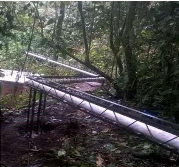
Se emplea tubería PVC de 4, 3 y 2" en las tuberías principales para presiones de 200, 160, 130 y 100 psi según la presión en cada sector. En la red de tuberías principales se especificaron válvulas alivio de aire y válvulas de quiebre de presión para asegurar la uniformidad en el riego.
