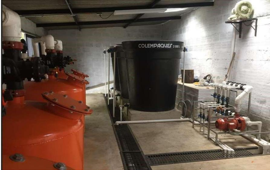
Fig 3. Filtrado y sistema de inyección. Soplador para agitar los fertilizantes
