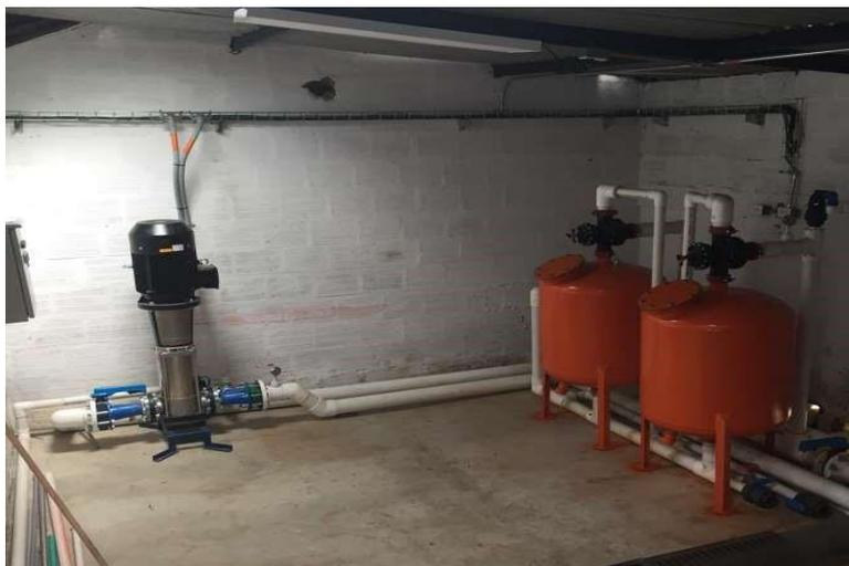
Fig. 2 Bomba multietapa y filtros de arena de lavado semi automático.
